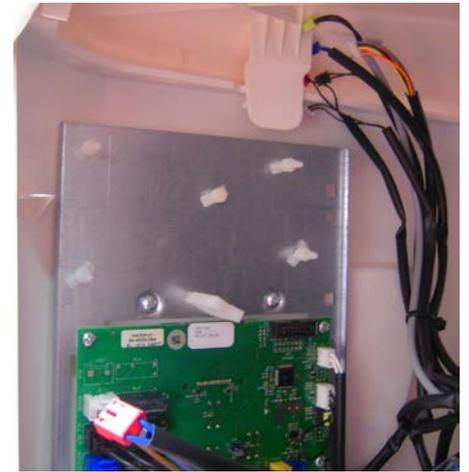
5) Mettre en place la nouvelle carte et rebrancher les connecteurs (sauf J1-bobine détenteur) et les câbles rouge et noir comme à l'origine
