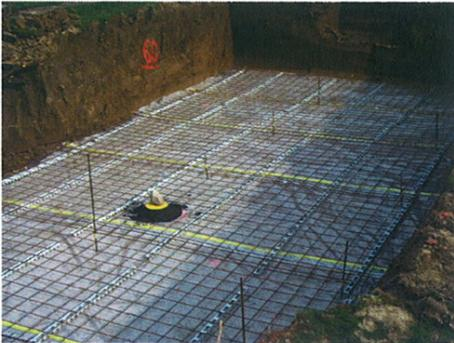
**Le ferrailage du radier** sera réalisé à l'aide de 2 nappes de treillis soudé : la première posée sur des cales pour les soulever de terre, la deuxième posée sur écarteurs de 7 cm afin d'obtenir une nappe haute et basse.
