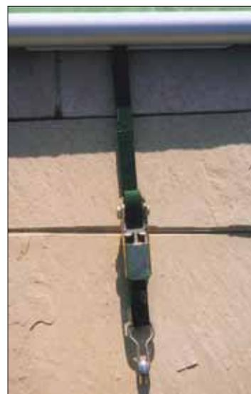
NOTA : Dans le cas de pitons douille présentant un léger jeu dans le dallage suite à un défaut de perçage, il est possible d'ovaliser la douille au moyen d'un marteau afin d'améliorer la tenue de celui-ci.
